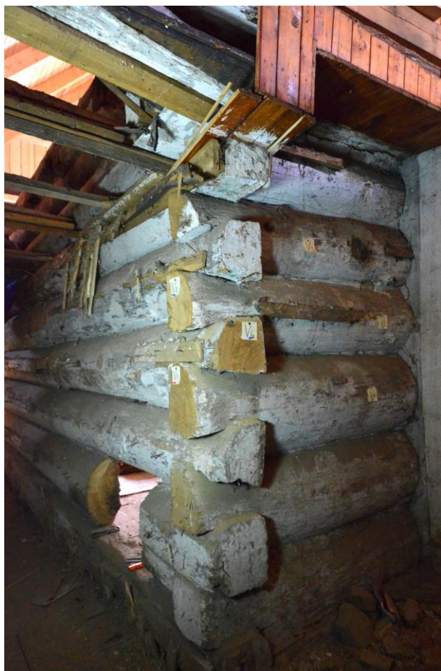
Obr. 9. Pohled na odkryté nároží velké roubené světnice z druhé poloviny 17. století městského domu č. p. 362 v Příboře (okr. Nový Jičín). Foto J. Koudelová, 2015.
