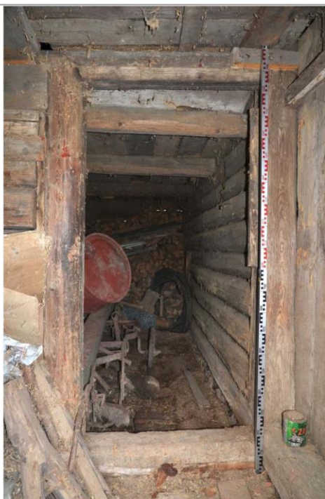
Obr. 03 Pohled do roubené komory stodoly u č. p. 1003. Foto O. Schejbal, 2013.
