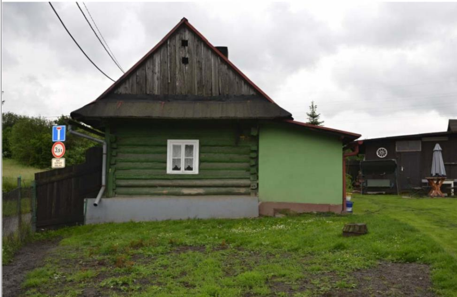
Obr. 06 Severní štítové průčelí domu č. p. 81. Foto J. Koudelová, 2014.
