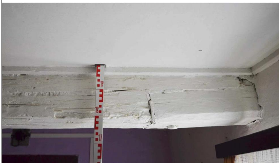
Obr. 05 Část měněného východního konce stropnice v prostoru menší světnice domu č. p. 81. Foto J. Koudelová, 2014.
