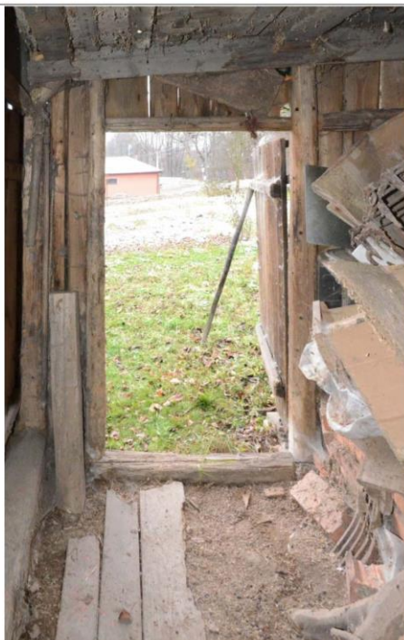
Obr. 02 Pohled do vstupní prostory (chodby) stodoly u č. p. 1003. Foto O. Schejbal, 2013.
