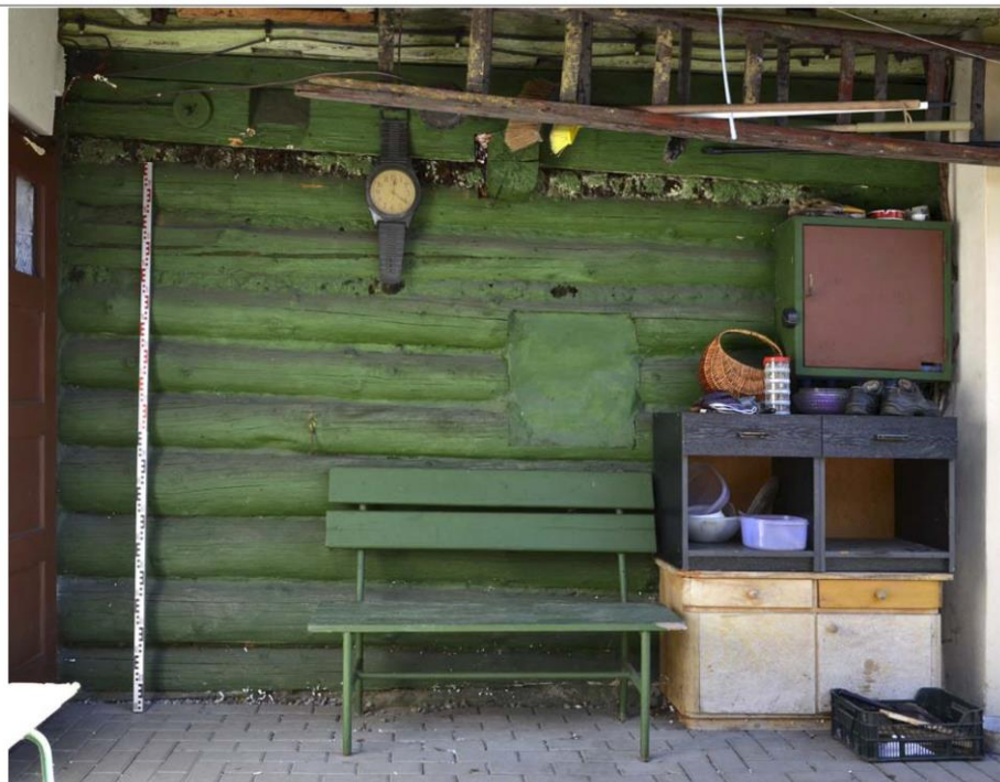
Obr. 02 Roubená část západního průčelí domu č. p. 81. Foto J. Koudelová, 2013.
