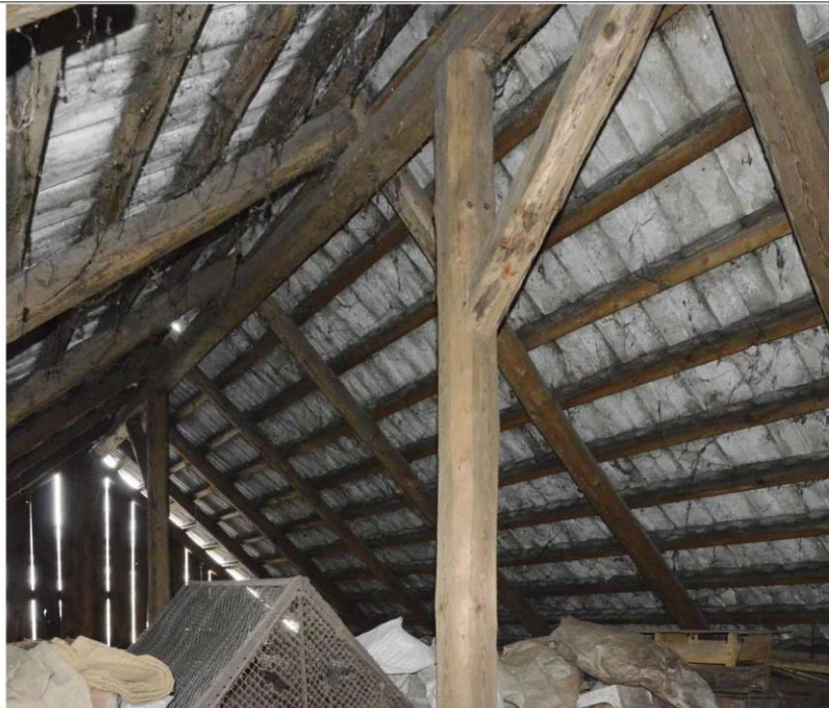
Obr. 06 Pohled do krovu stodoly u č. p. 1003 od jihozápadu. Foto O. Schejbal, 2013.
