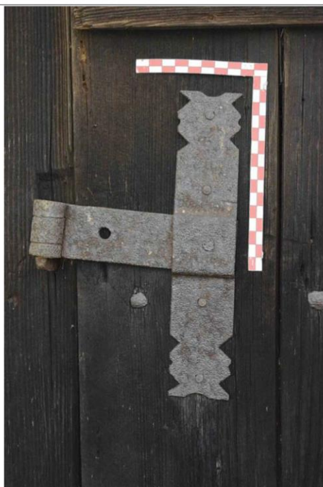
Obr. 05 Křížový závěs u dveří v jižním průčelí stodoly u č. p. 1003. Foto O. Schejbal, 2013.
