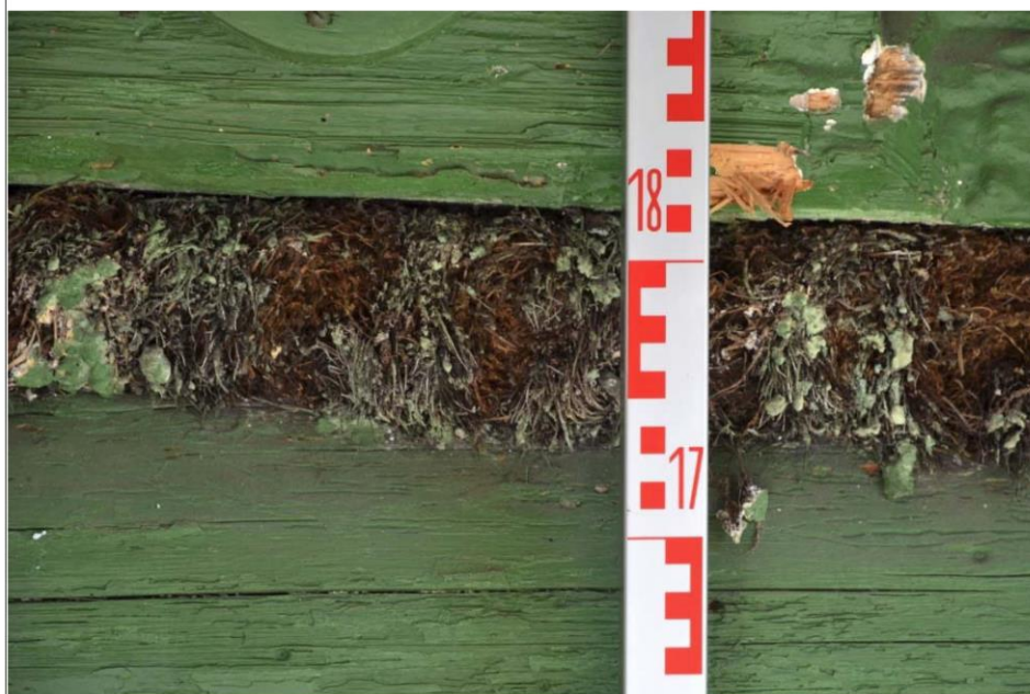
Obr. 04 Detail výplně spáry v podobě provazců mezi trámy západního průčelí domu č. p. 81. Foto J. Koudelová, 2014.
