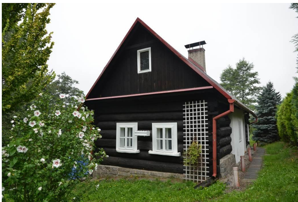
Obr. 6. Pohled na dům č. p. 90 ve Vratimově – Horních Datyních (okr. Ostrava-město) od severovýchodu. Foto J. Koudelová, 2015.
