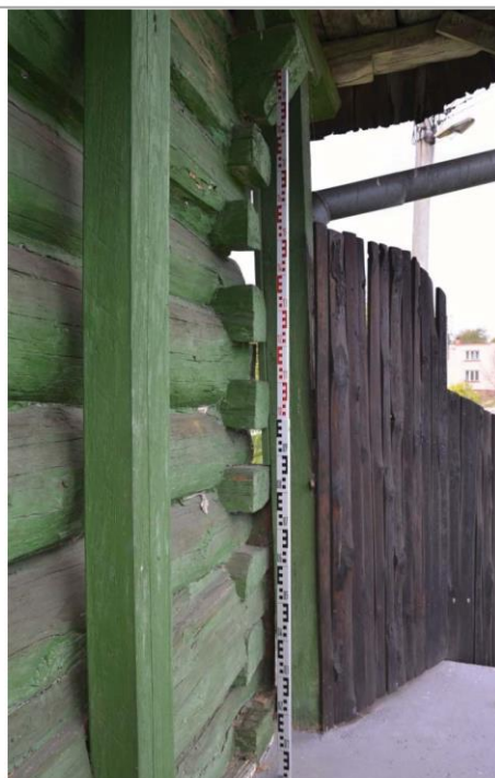
Obr. 03 Detail roubené konstrukce, včetně nároží, východního průčelí domu č. p. 81. Foto J. Koudelová, 2013.
