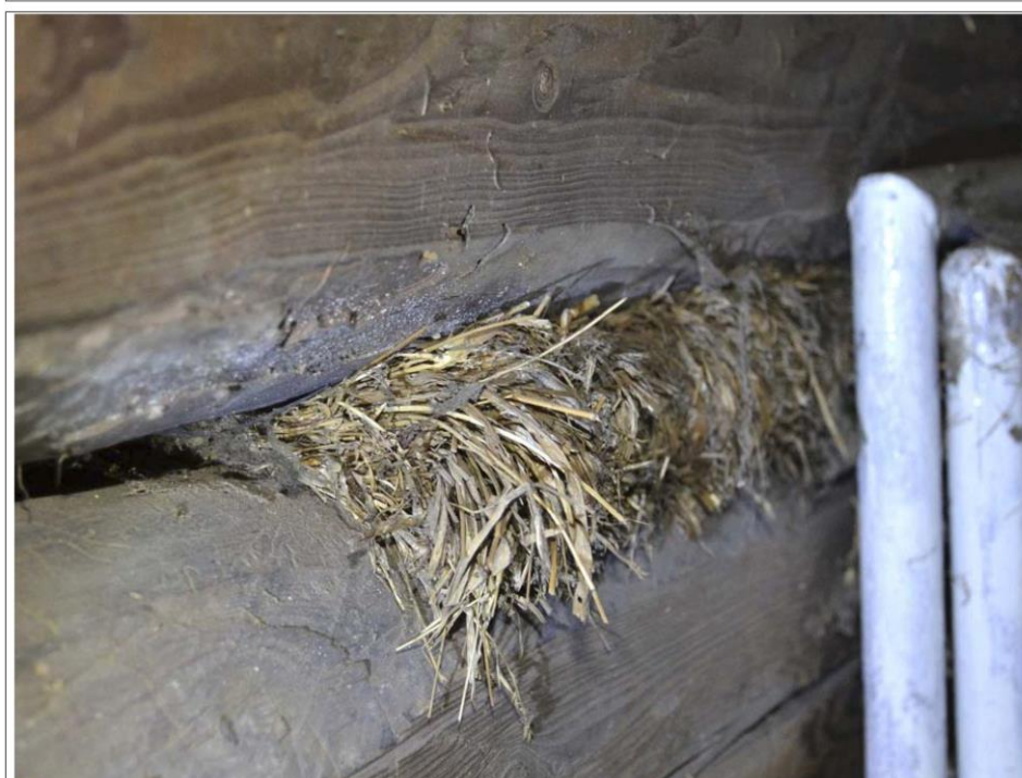
Obr. 07 Detail výplně spáry mezi trámy roubení stodoly u č. p. 1003. Foto O. Schejbal, 2013.
