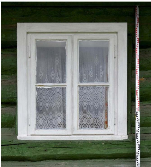
Obr. 02 Okno osazené v severním průčelí domu č. p. 81. Foto J. Koudelová, 2013.
