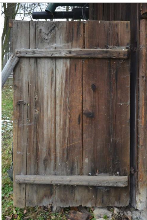
Obr. 04 Vnitřní strana dveří v jižním průčelí stodoly u č. p. 1003. Foto O. Schejbal, 2013.
