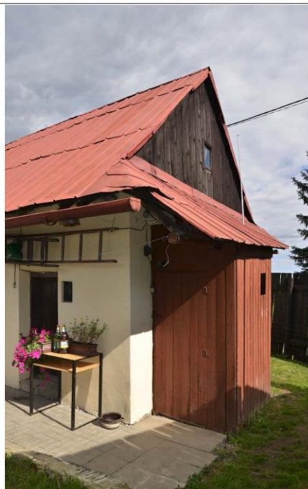
Obr. 08 Jihozápadní nároží domu č. p. 81 s dřevěnou přístavbou suchého záchodu. Foto J. Koudelová, 2014.
