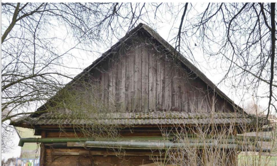
Obr. 03 Západní štít s podlomením stodoly u č. p. 1003. Foto O. Schejbal, 2013.
