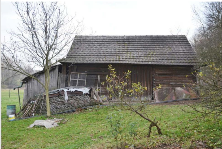
Obr. 08 Severní průčelí stodoly u č. p. 1003. Foto O. Schejbal, 2013.
